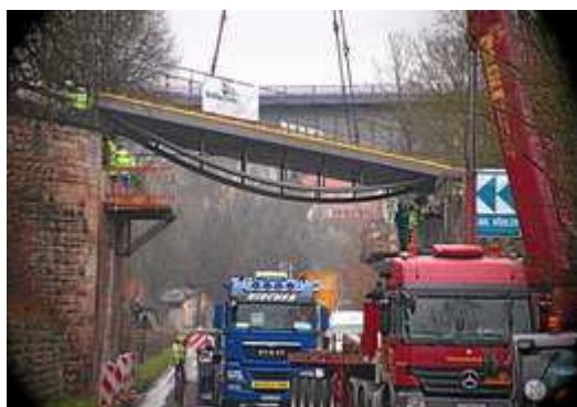
Die 35 Tonnen schwere Stahlbrücke wird angebracht. Fotos: Alfred Drossel
